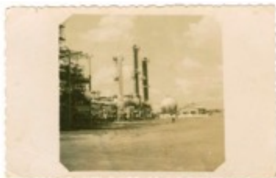
Refinería de Barrancabermeja
